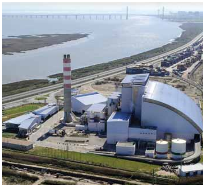
Valorsul位于葡萄牙S. João da Talha的垃圾焚烧发电厂
