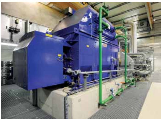
ABB 15.5 MW的4极电机驱动其中的一台天然气压缩机（资料来源：RAG/Steve Haider）
