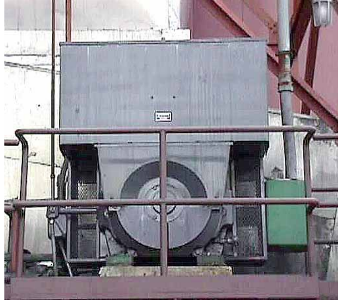
这台已经用了20年的固定转速风机电机如今由ACS 1000变频器驱动，工作效率提高，噪音减少。
