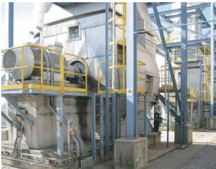
Valorsul的垃圾焚烧发电厂的三台引风机，如今通过ABB的ACS 2000变频器控制。
