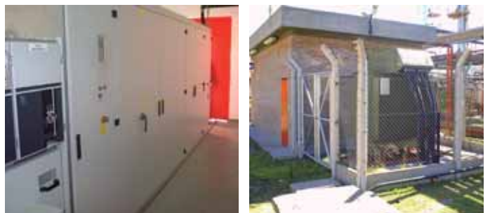
此图所示为通过ACS 1000变频器驱动电机、变频器柜里的ACS 1000变频器、变频器柜和三绕组输入隔离变压器。
