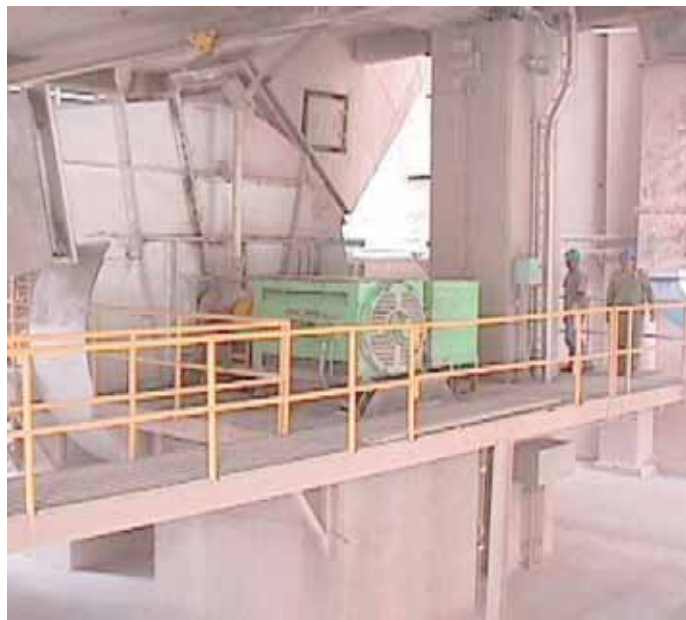
这台已经用了10年的固定转速风机电机如今由ACS 1000变频器驱动，工作效率提高，噪音减少。
