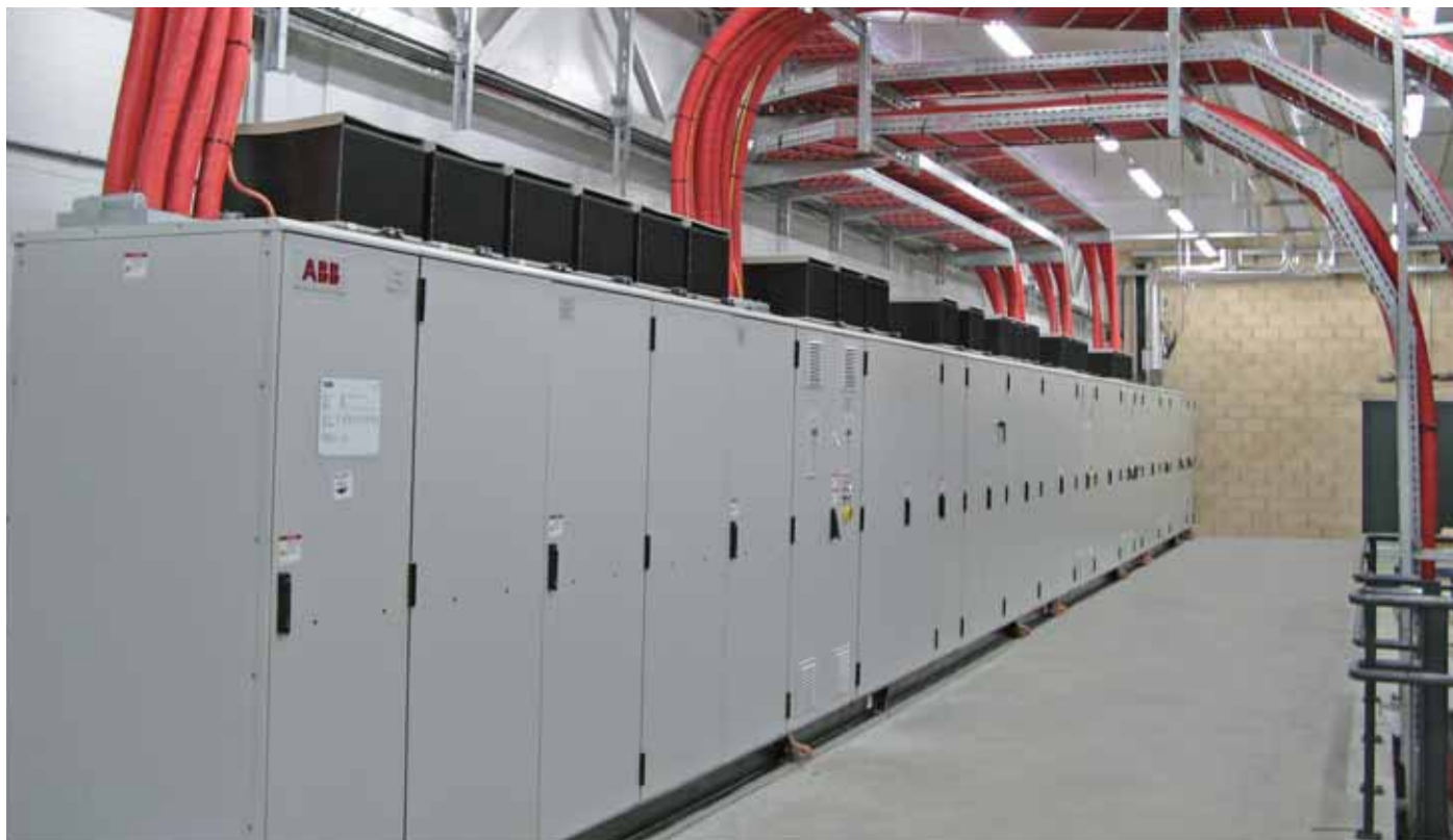
总额定功率为36 MVA、用于控制CENER的试验台的ACS 6000多传动变频器。
