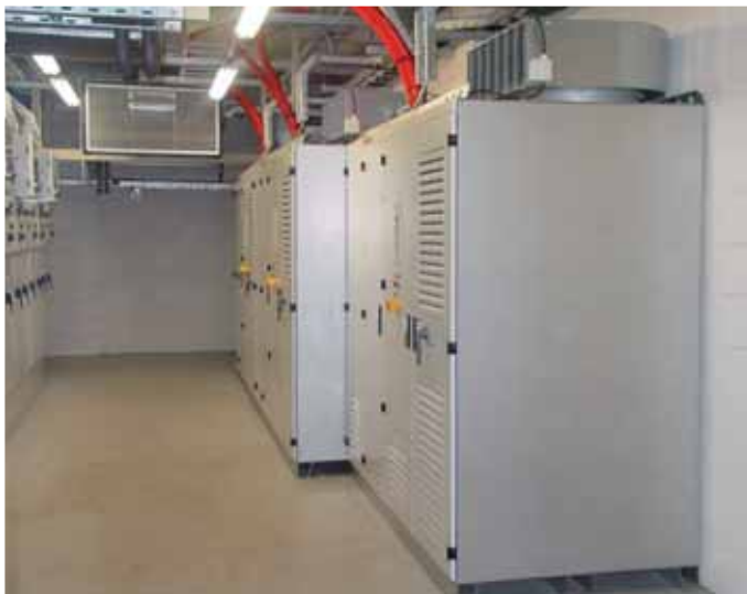
3台额定功率为700 kW、可直接与电网连接的ACS 2000变频器，被用于控制Valorsul垃圾焚烧发电厂的引风机。
