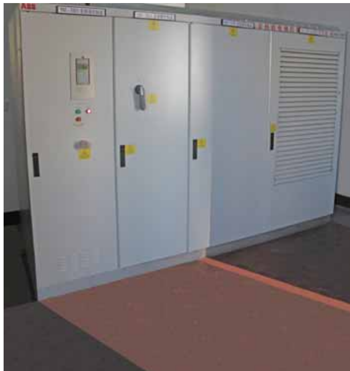
中国大庆石化塑料厂用于控制密炼机的ACS 1000变频器
