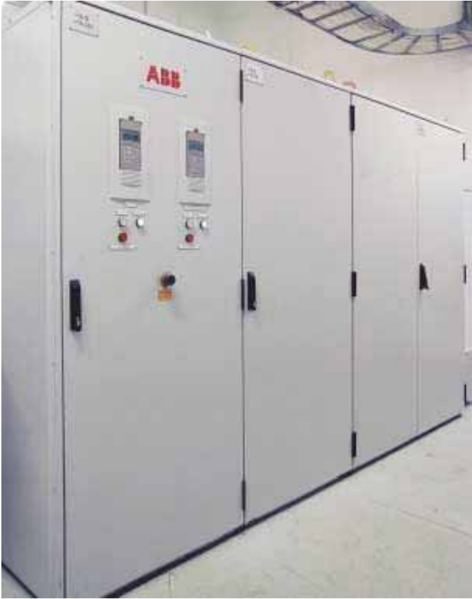
图5. ACS 6000SD同步电机变频器。
